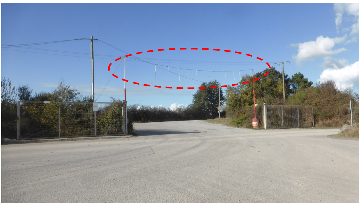
Figure 6 - Gabarit de sécurité en sortie de site
