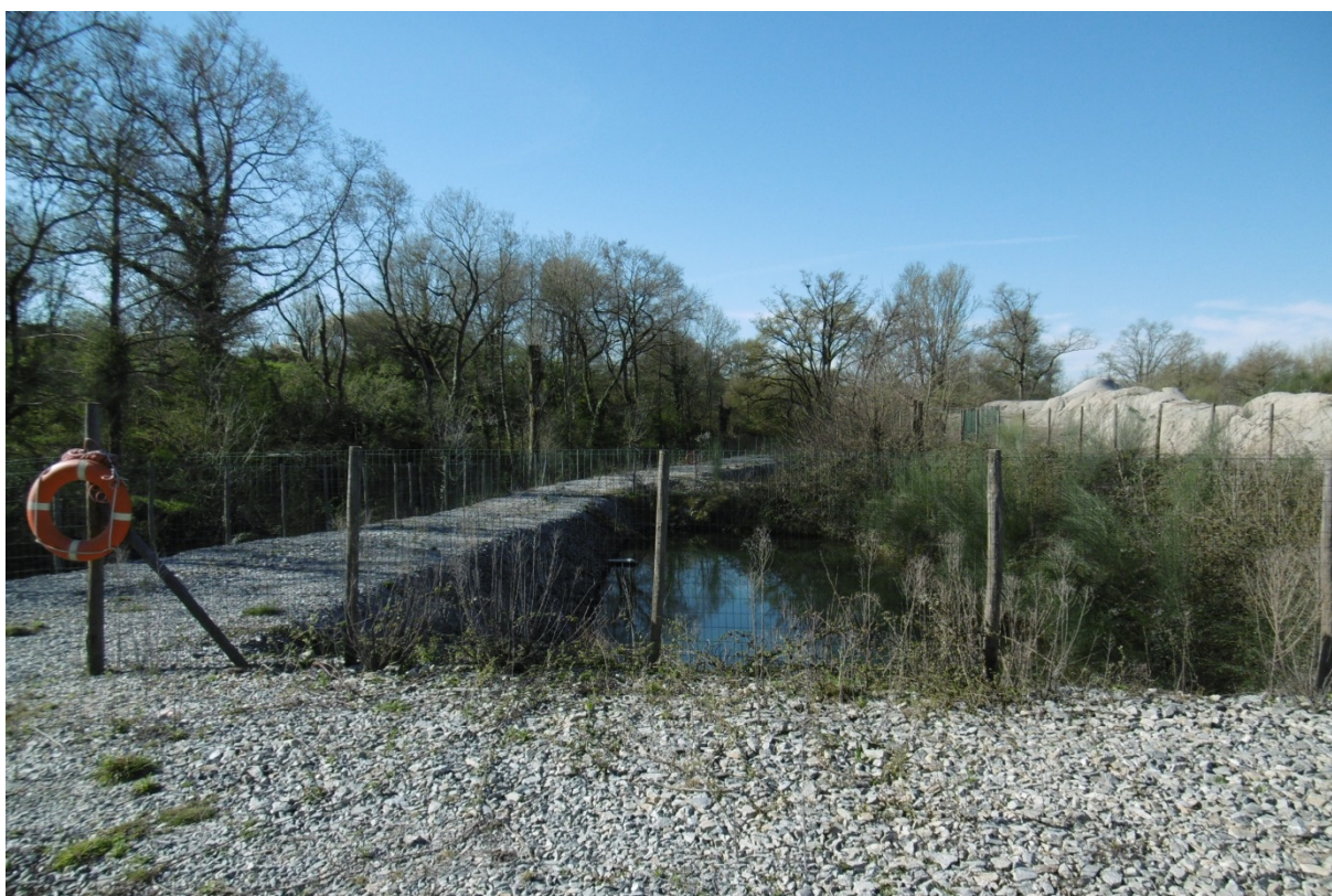
Figure 5 - Clôture et système de sécurité en place autour du bassin de décantation existant
